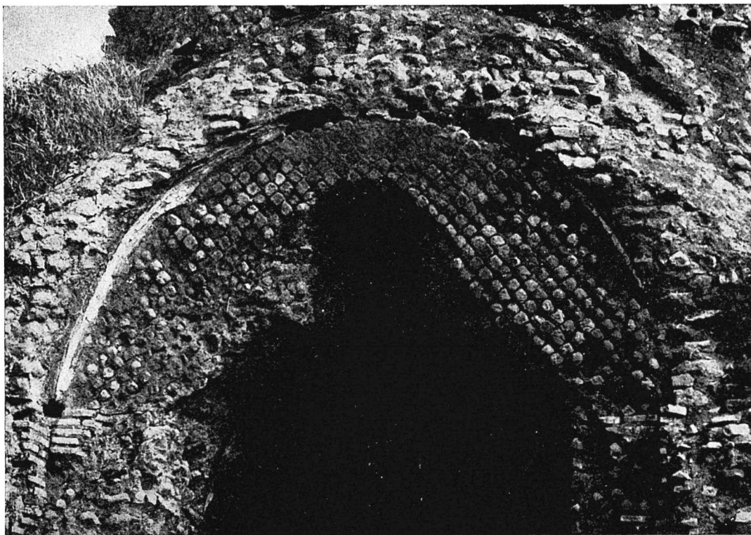
FIG. 15 - Torraccia dell'Inviolata: lunetta del vestibolo.
