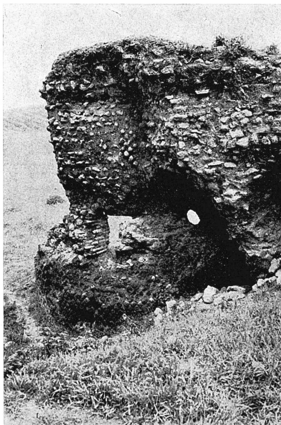
FIG. 5 - Torraccia dell'Inviolata: imposta della volta del vano a .
