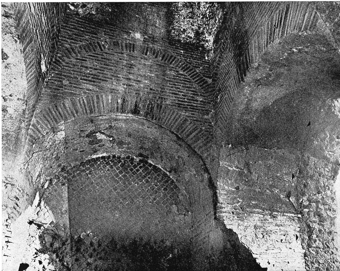
FIG. 11 - Torracchia dell'Inviolata: part. del lato nord della cella.
