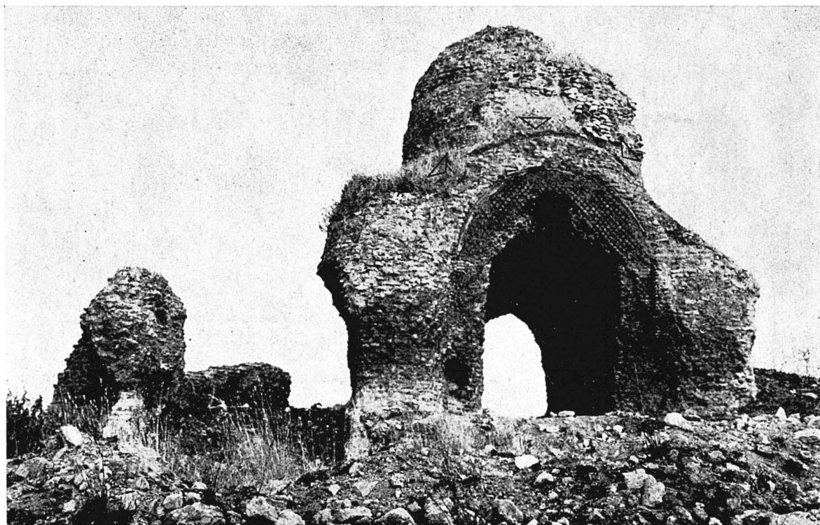
FIG. 2 - Torraccia dell'Inviolata: lato ovest.
