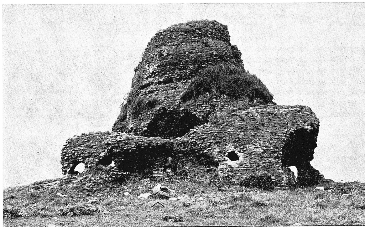
FIG. 6 - Torraccia dell'Inviolata: lato nord.
