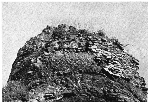
FIG. 24 - Torraccia dell'Inviolata: resti della muratura medievale.
