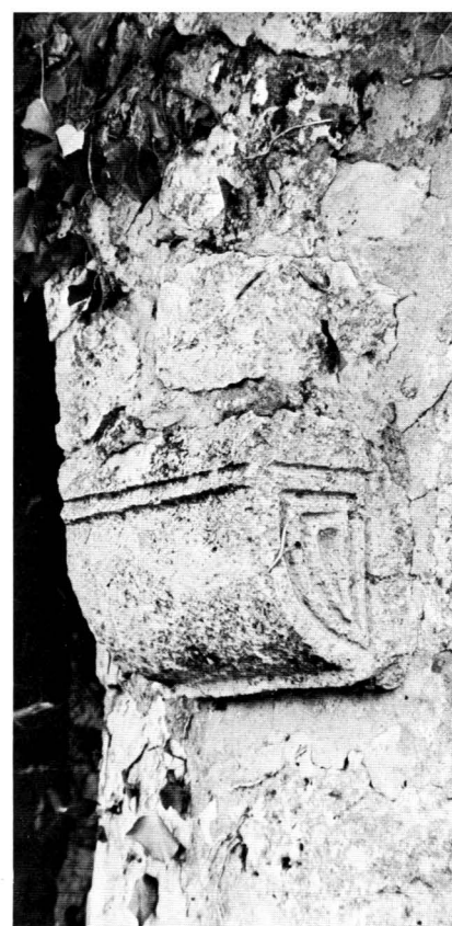
Fig. 115 - Montecchia di Crosara, S. Salvatore. Abside settentrionale, mensola di sostegno agli archi. ▶
