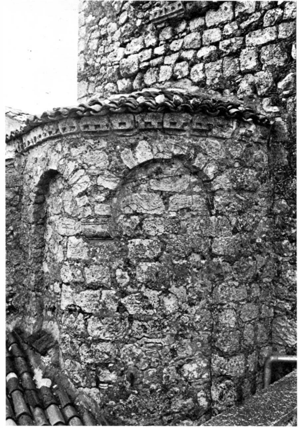
Fig. 106 - Montecchia di Crosara, S. Salvatore. Abside settentrionale.
