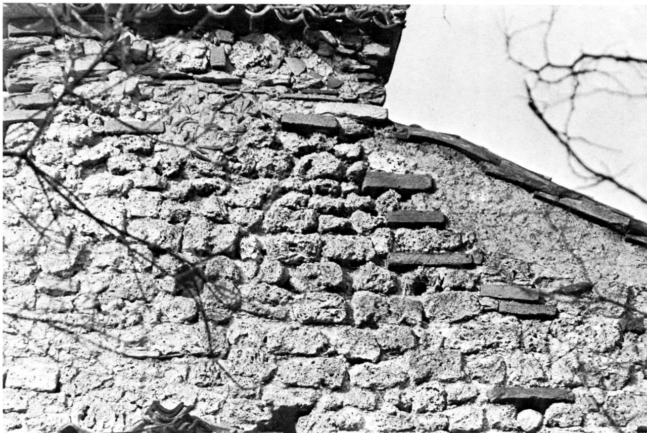
Fig. 112 - Castelseprio, S. Maria foris portas . Muratura del timpano.
