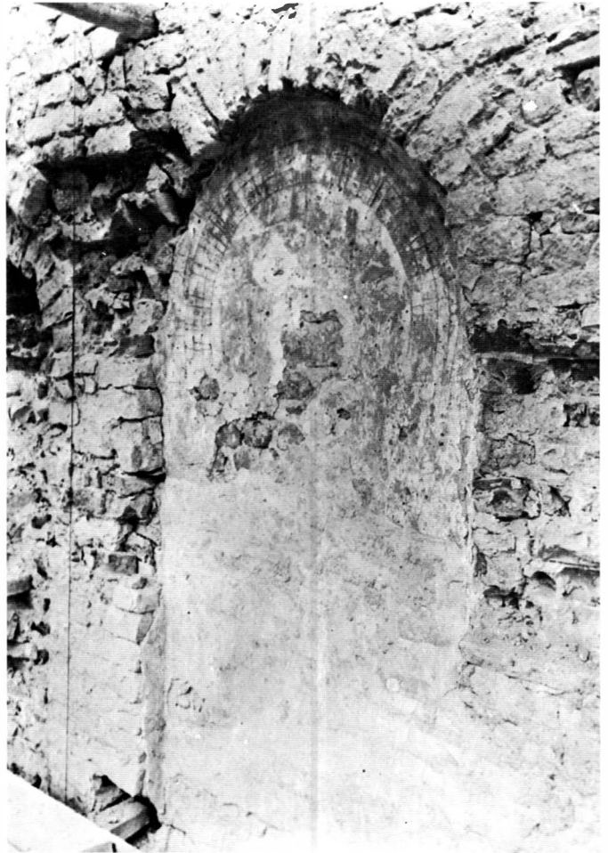
Fig. 73 - Pavia, S. Felice: arcatura con intonaco graffito (durante i restauri).
